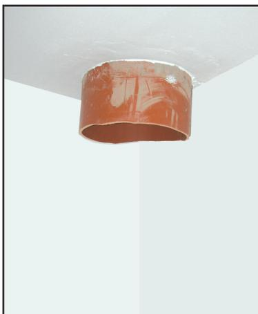
Das KG-Rohr wird bis auf wenige Zentimeter gekürzt.
